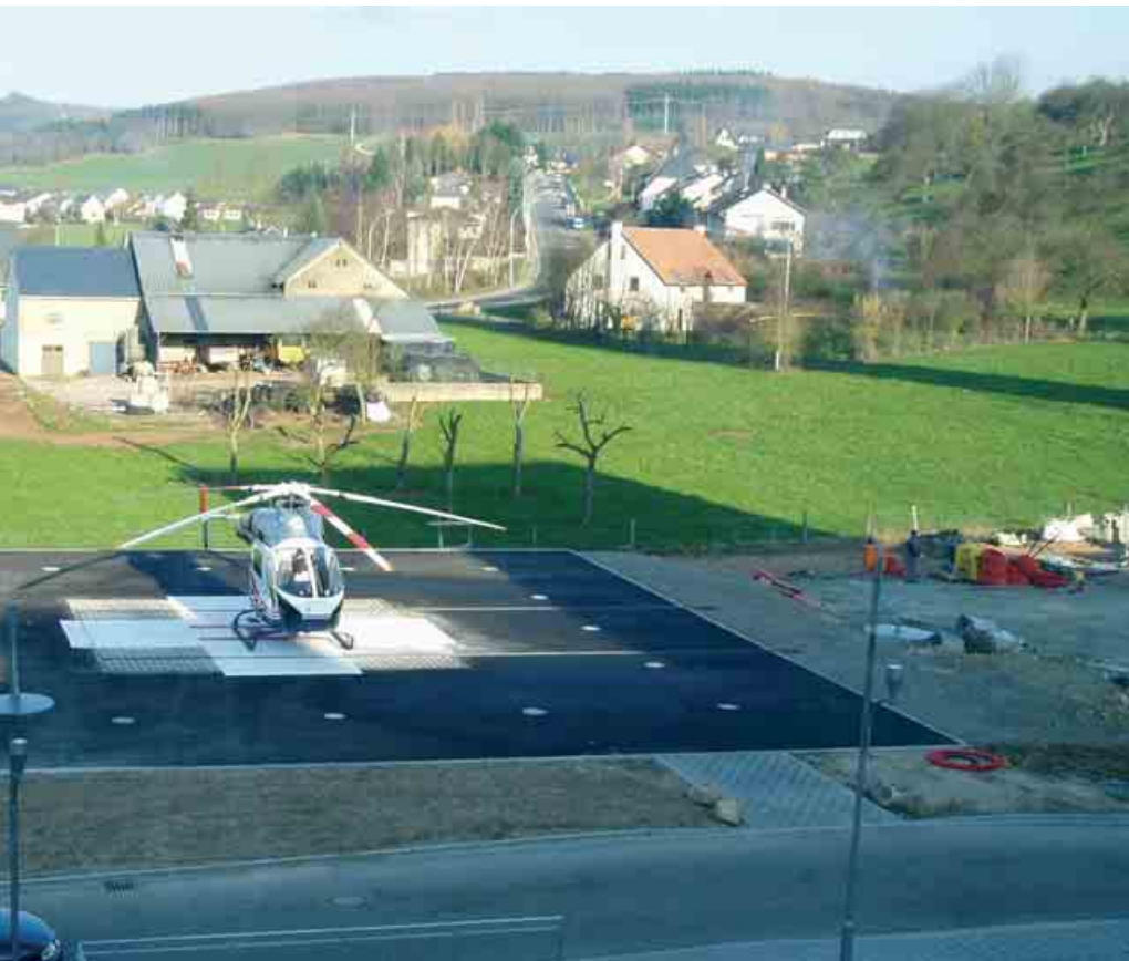
Was im November zügig voranging, ist nun abrupt gestoppt worden: Der Bau des Hangars in Ettelbrück. Auf diesem Foto zu sehen: der heute bereits fertiggestellte neue Landeplatz für den Rettungshubschrauber, rechts davon der Bauplatz für den Hangar
